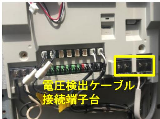
I o r 測定のための接続が終わっても、絶縁監視装置の電源を入れただけではI o r 測定は行われません。このまま手順書に従って作業のこと。
