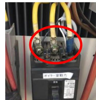
予備のMCCBがない場合は、子ブレーカーを設置し、1次側にケーブルを接続する。**作業は停電させて実施。**
